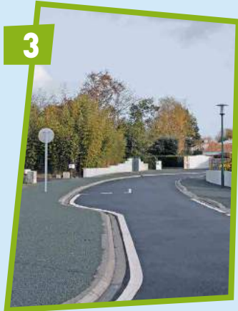
Voirie chemin du Bois Ménard 2016
