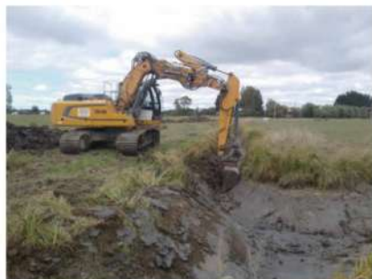
Curage des fossés d'intérêt collectif
