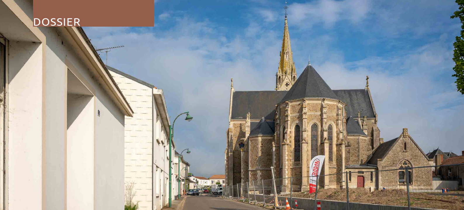
L'église après les travaux (Crédit mairie de Soullans)
